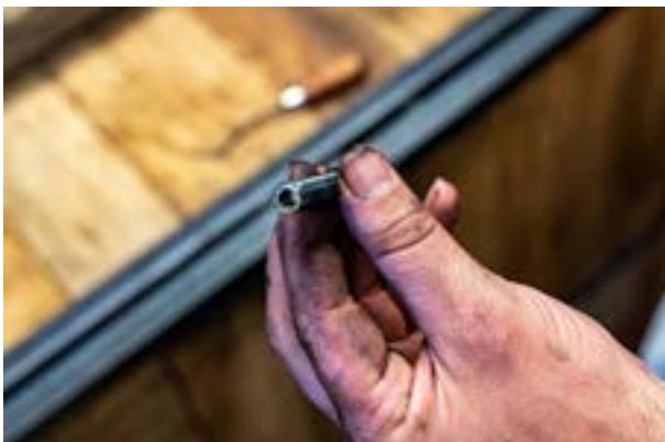
Montieren Sie die Inspektionsdeckel mit ca. 5mm Abstand auf den Primärdeckel um eine Durchlüftung des Primärkastens zu erzeugen (z.B. Hülsen oder Scheiben zwischen den Deckeln und dem Kasten unterlegen).
