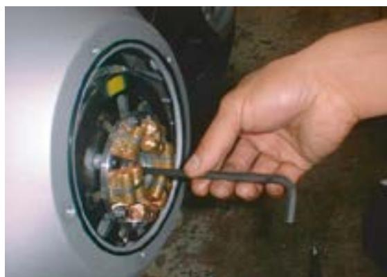
3. Utilizando una llave de tubo de 10 mm, afloje uniformemente la retención del resorte destornillando los 6 tornillos M6x16 de cabeza brida da un poco cada uno. Retire la retención del resorte y los tornillos, y apártelos a un lado.
